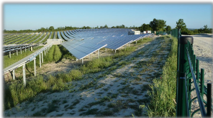
Exemple de piste en cours de ré-enherbement en fin de travaux (Photo Ectare)
